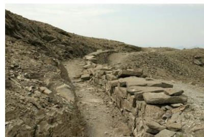
Le canal et le mur de soutènement avant d'arriver à la cabane
